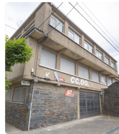
Edificio de Sindicatos
