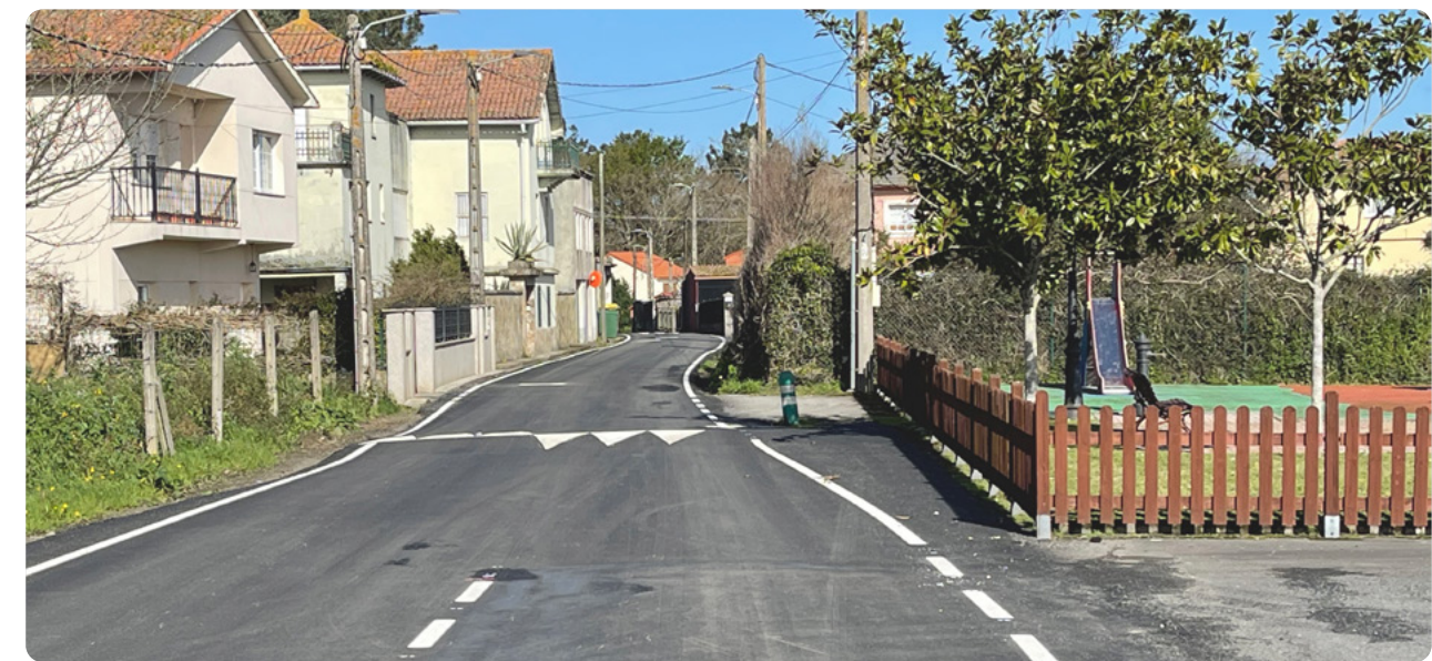
Asfaltáronse cerca de trinta quilómetros de viais
